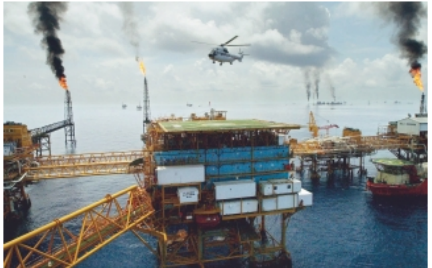
Ölplattform im Golf von Mexiko, hier wird Öl bis in Tiefen von über 1500 Metern gefördert.
